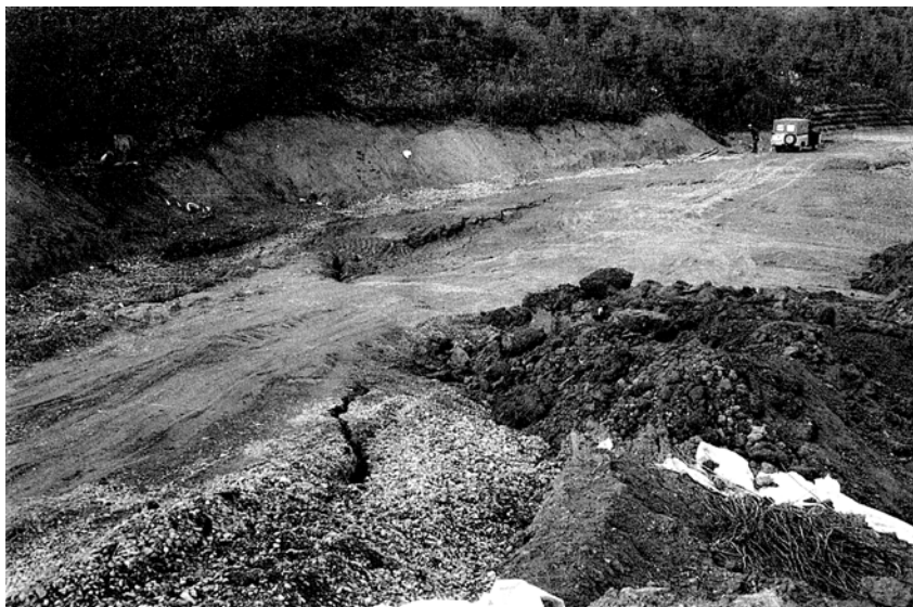
第 39 図 大川層分布域に見られる地すべり現象。駒島-茂岩間の道路が地這りによって滑動するため、地すべり防止対策がほどこされている（駒島北東 2.5 km 付近）
