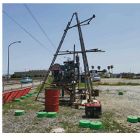
地下を探るためのボーリング掘削。
