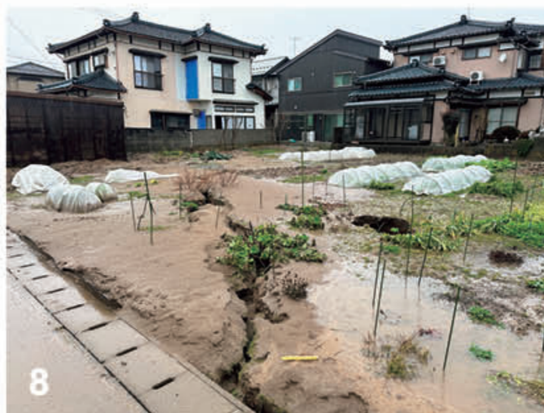
写真7, 8 旧信濃川流路での液状化被害（新潟市西区善久）。 旧流路は、深度12 m程度までN値5-10程度の砂層から構成されている。地下水位は地表下1 m程度であり、SWS試験による地盤強度評価では地下水位よりさらに2 m程度下位までの層準が液状化したものと推定できる。写真7の出典：ト部ほか（2024b）。写真8の出典：新潟大学災害・復興科学研究所（2024）。
