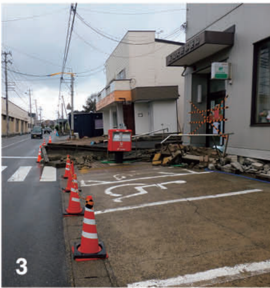
写真3 海岸砂丘の内陸側緩斜面末端での圧縮変形（新潟市西区内野・大野、県道16号沿い）。 砂丘の内陸側斜面末端部において液状化が発生したため、背後（写真右側）の砂丘緩斜面全体が、内陸側に移動した。このような砂丘斜面末端部での引張亀裂と圧縮変形は、新潟市西区内野から青山地区にいたる約10 kmの区間で発生した。撮影：新潟大学災害・復興科学研究所。
