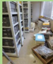
試料コンテナを乗せたまま水平に1m弱移動した試料ラック。もともとの位置は床面にある「J」の場所
