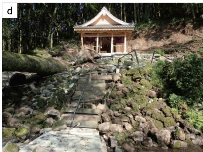
写真 a, b: 野菜やマルチの畝が断層によって右横ずれしている様子。写真 c: あぜ道と稲の畝が左横ずれしている様子。右横ずれ断層どうしをつなぐ位置に左横ずれ断層がある。写真 d: 神社に上る階段が右横ずれしている様子（益城町文化財に指定）。
