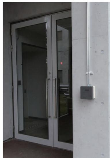
写真3 7-3A棟北側入口に設置された電子錠。
